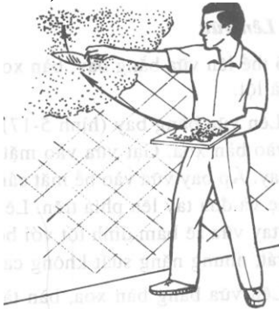
Hình 1-12: Vẩy vữa lên tường bằng bay
