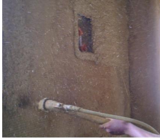
Hình 1-13: Lên vữa bằng máy (plastering machine)
