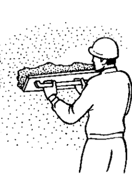
Hình 1-11 : Lên vữa bằng bàn tà lột
