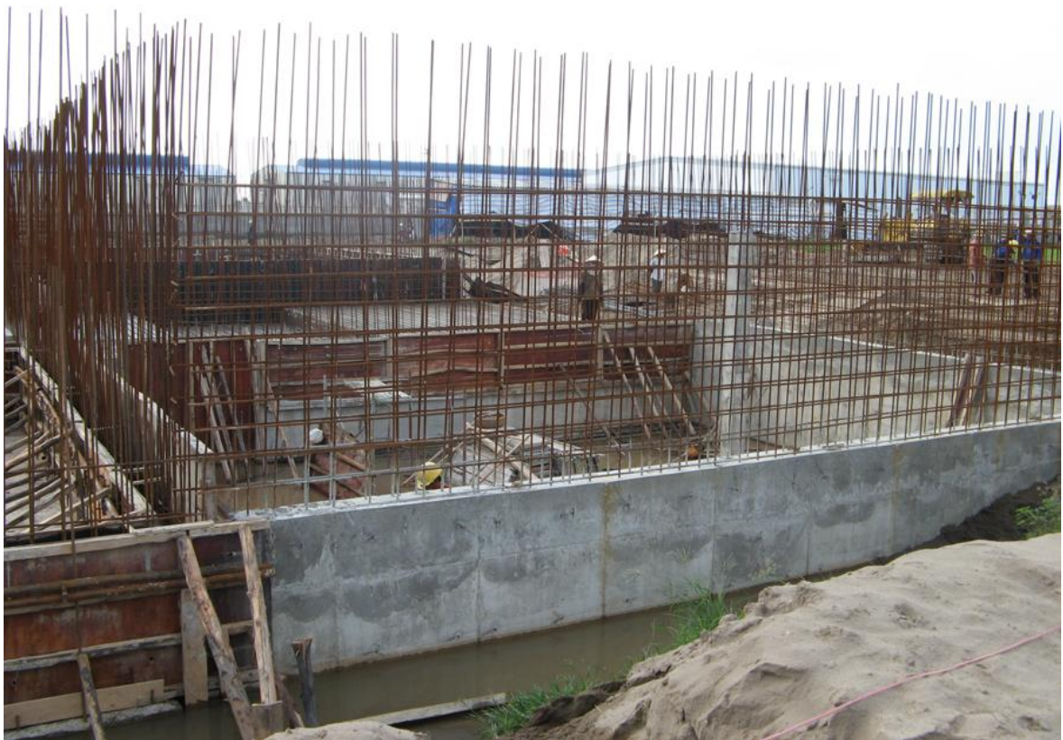
Hình 11-1. Hình ảnh cốt thép tấm tường trên công trường.
