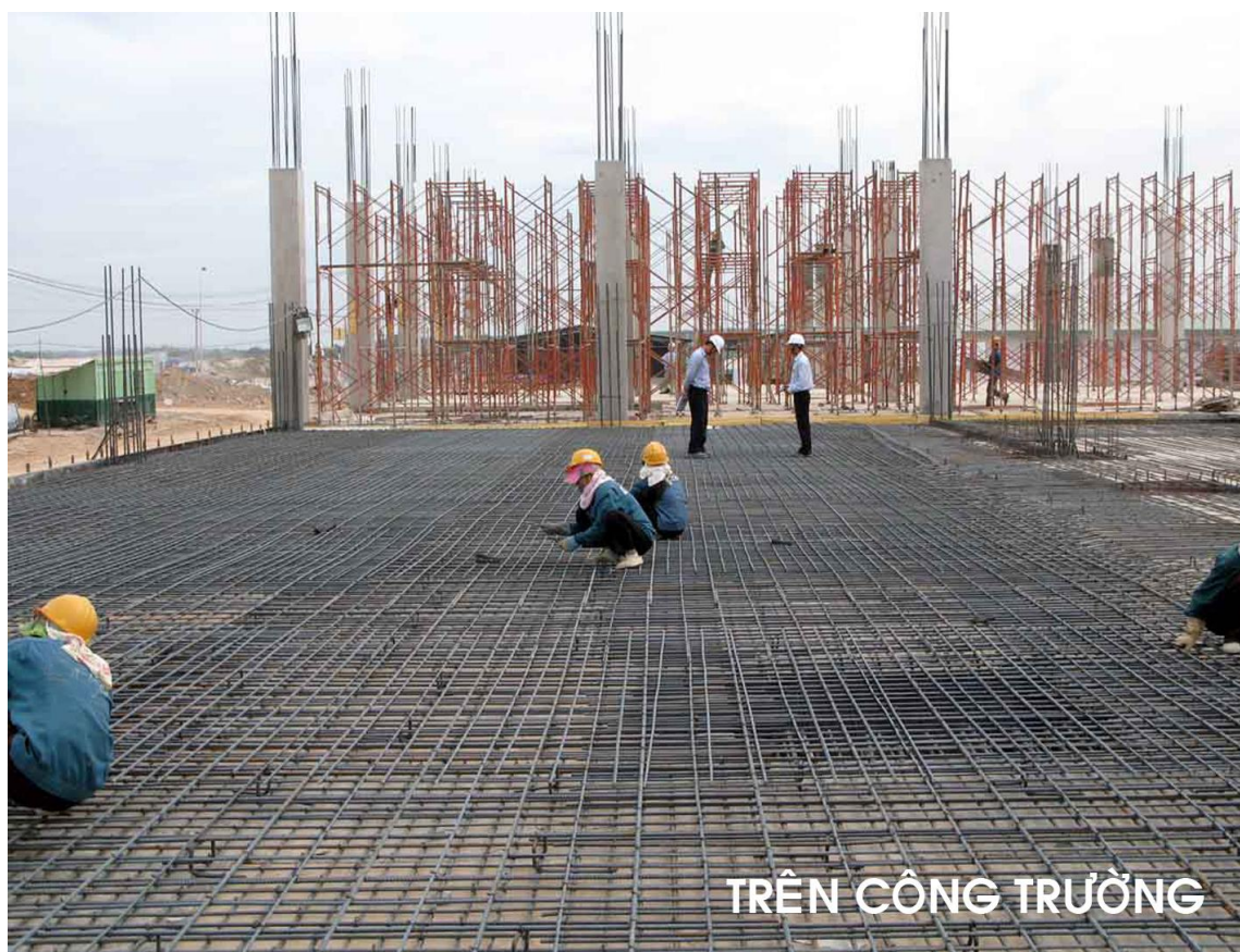
Hình 15-3. Cốt thép dầm sàn toàn khối
